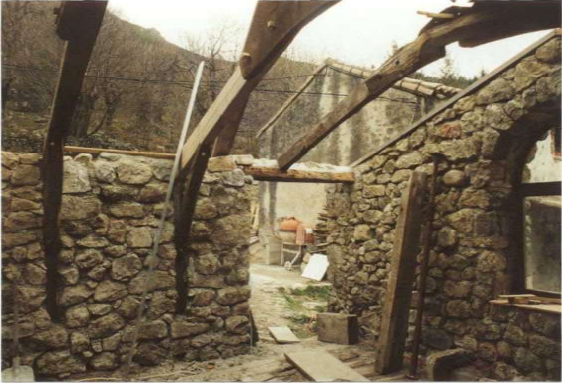
Entrée haute moulin 2004
